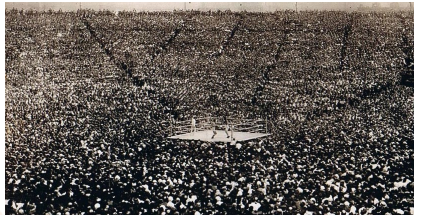
Tymczasowy obiekt sportowy dla ponad 90 tysięcy widzów zbudowany przez Texa Rickarda, walka Jacka Dempsey'a vs. Georges Carpentiere'a.
